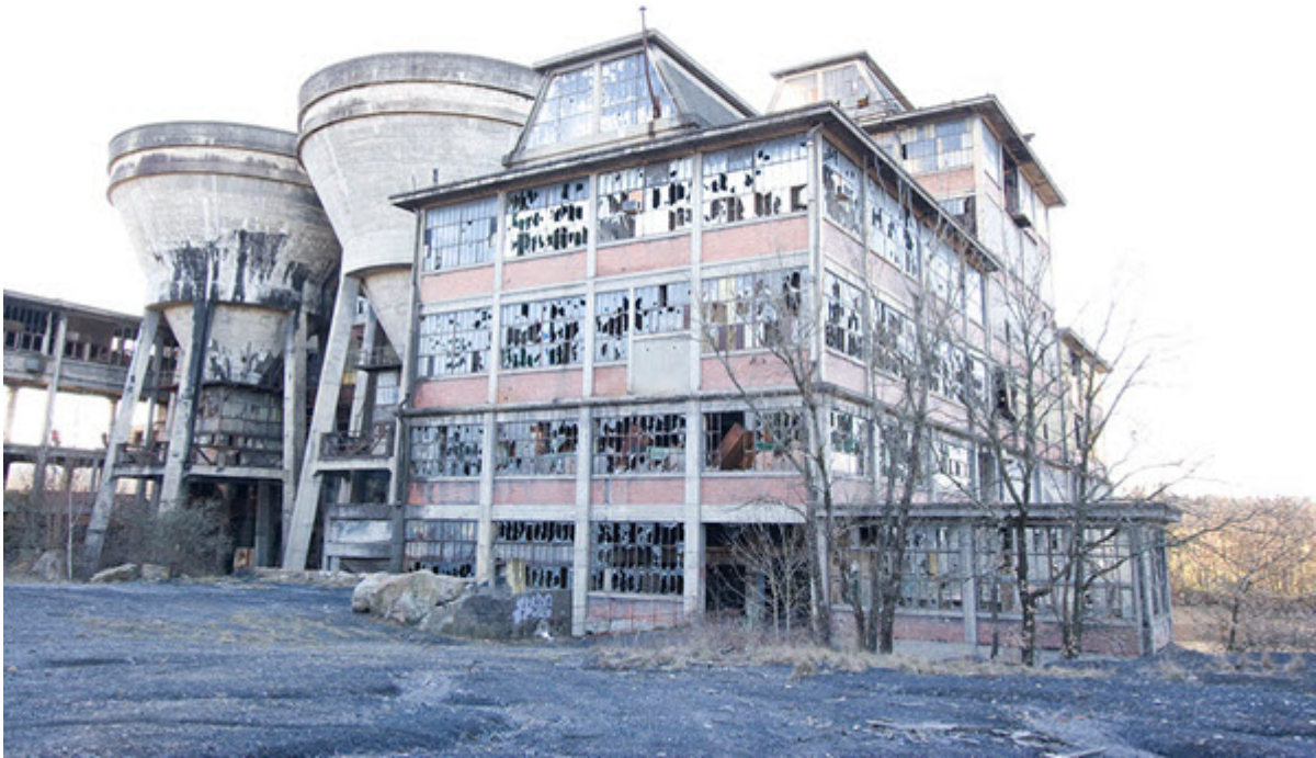
photo sur-exposée de 4 EV (+ 4Ev)
